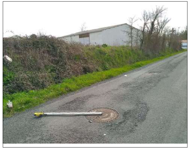
référence nivellement (tampon sur voirie)
