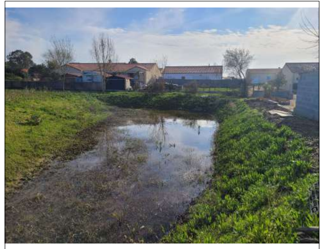
Vue du bassin d'eaux pluviales, coté Sud du lot 7.
