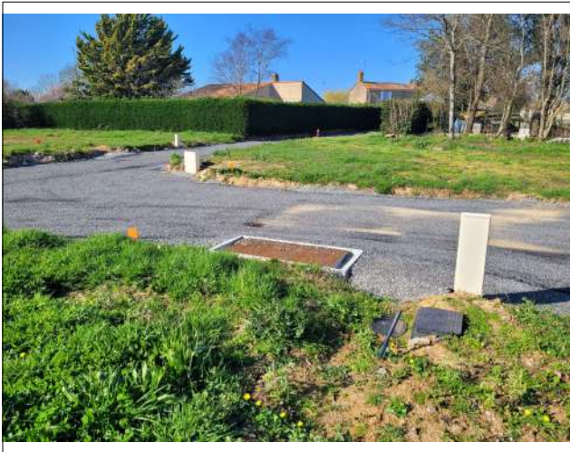
Vue de la référence nivellement : tampon télécom.
