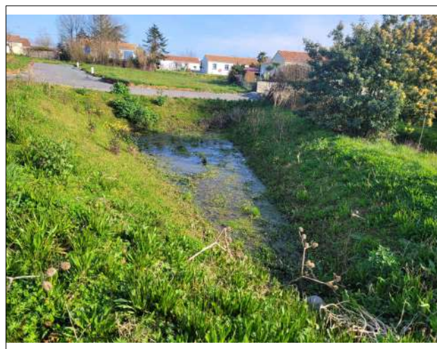
Vue du bassin d'eaux pluviales, coté Est du lot 7.
