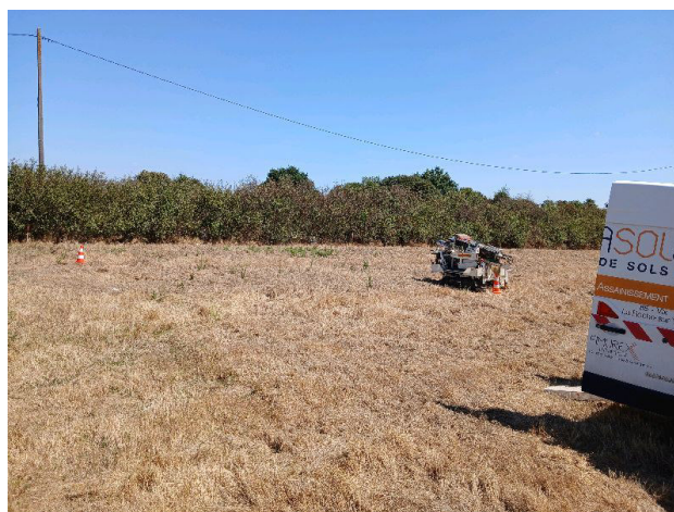
Vue vers le Sud-est Lot 14
