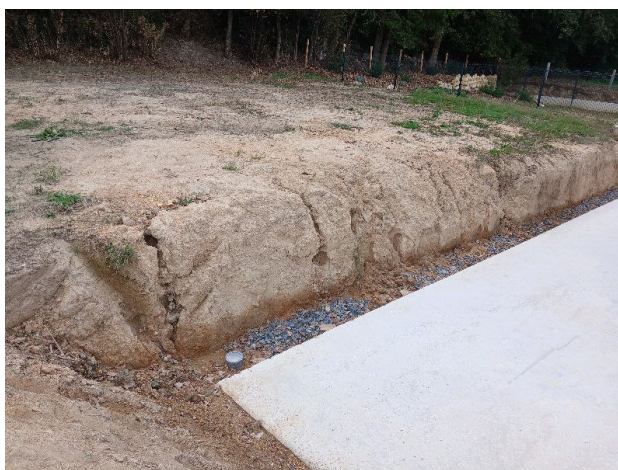
Vue vers le Sud-est : parois de fouilles de terrassement de l'avoisinant N1
