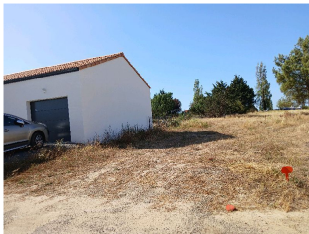
Vue vers la maison RDC avoisinante en limite de propriété notée N2
