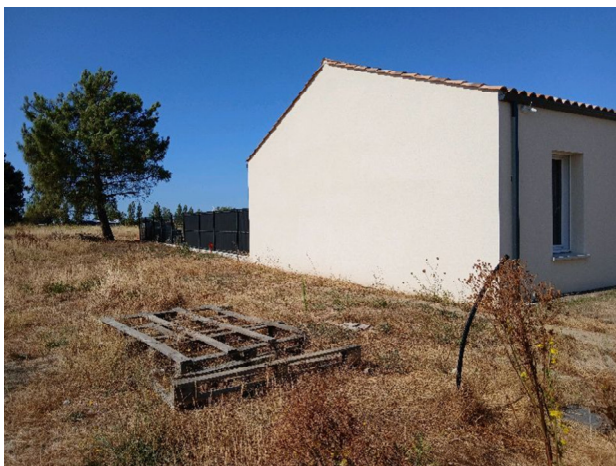
Vue vers la maison RDC avoisinante en limite de propriété notée N1
