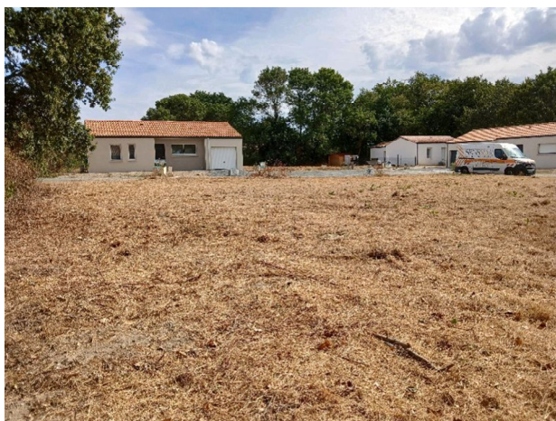
Vue vers le Nord-Est des lots 8-9
