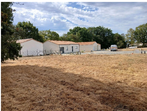
Vue vers le Sud du lot 3
